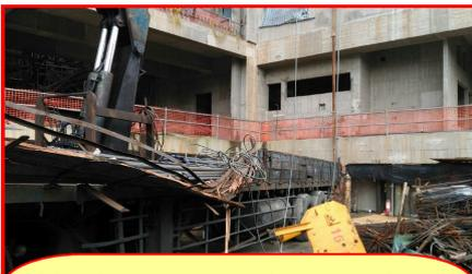
106年3月台北某工地，以起重機吊掛鋼筋，因減速機花鍵套磨損，吊舉物掉落，擊中下方吊掛人員，造成1死。
